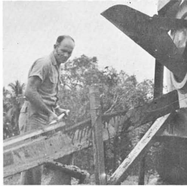
EO1 WEBB pouring concrete
