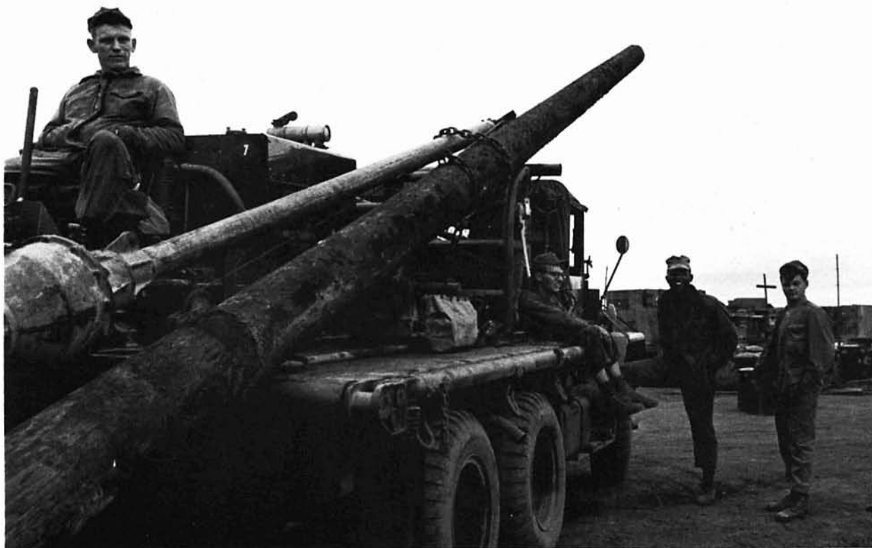
LINE CREW — CECN R. L. Heid, CE3 J. C. Rowland, CE3 L. L. Ambeau, CE3 T. R. Aspan.
