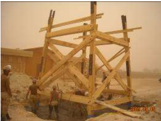
Seabees pour concrete footing
