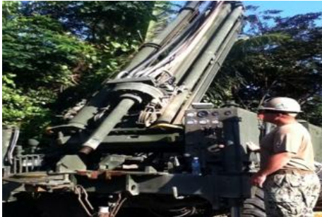
EO1 (SCW) Hill sets the ITWD rig.
