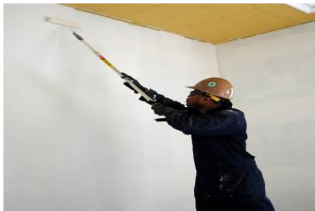
EOCN Morrison applying primer
